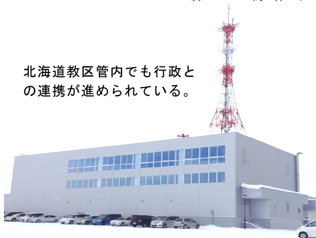
平成20年に出来た旭川市の防災センター。支部では行政との連携の相談を重ねている。
